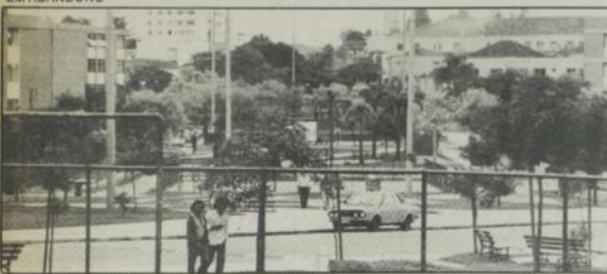
Muitos dos equipamentos instalados no Jardim Ambiental estão hoje a merecer reparos.
